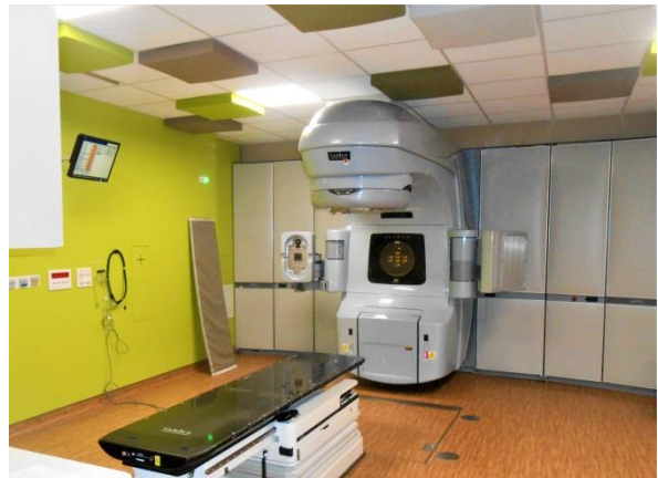
Salle de traitement (bunker) du clinac 3
